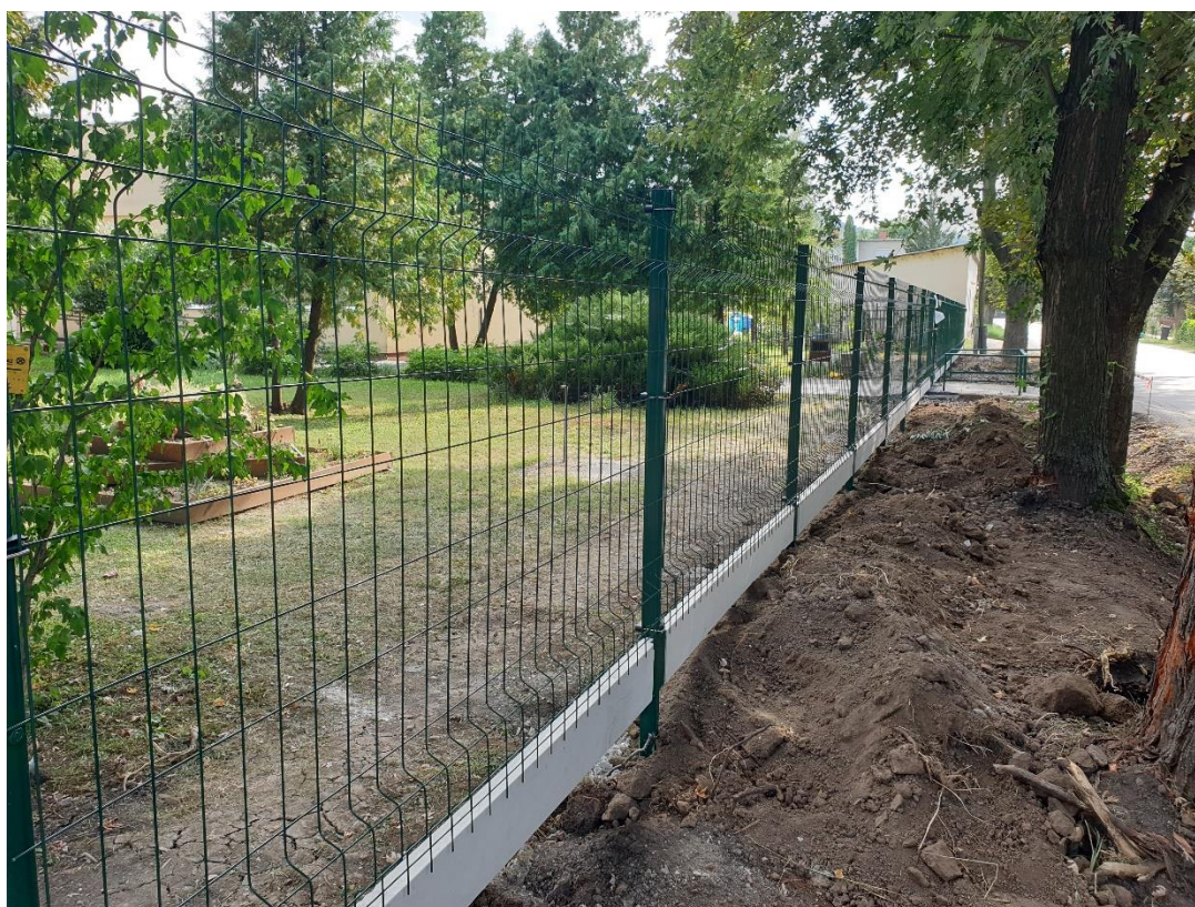
Központi Óvoda kerítés felújítás
