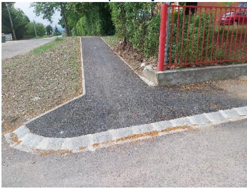
Vörösmarty úti járda (Élmunkás és Kandó Kálmán utcák közötti szakaszon) felújítása.
