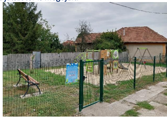
A Babóca játszótér felújítása.
