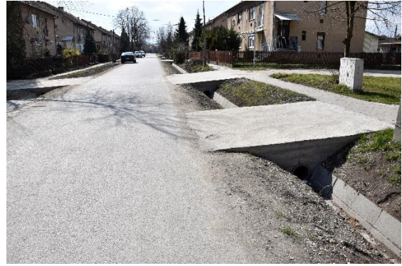
Új bel-és csapadékvíz elvezető rendszer a Harica és a Bányász utcában
