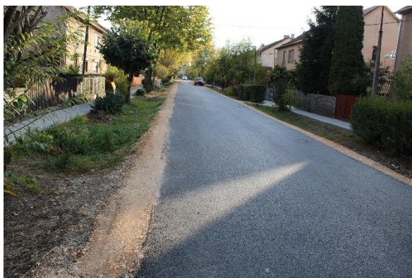
Útburkolat felújítás a Bányász utcában
