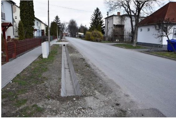
Új bel-és csapadékvíz elvezető rendszer a Harica és a Bányász utcában
