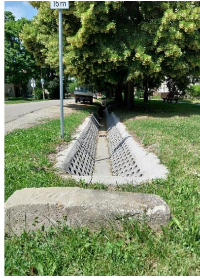
A Tárna utcában gyeprácsos szivárogtató is épült a bekötések elé.
