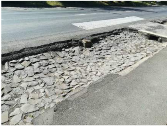
Extrém példa a vízvezető árok leburkolására
