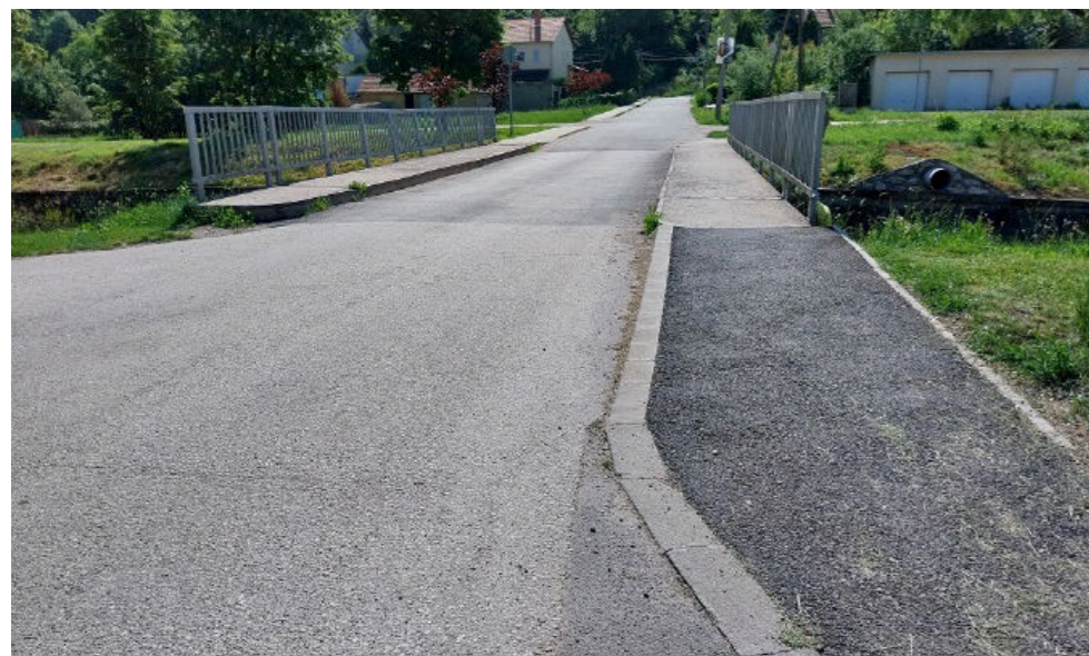
NYÖGŐ HÍDHOZ VEZETŐ JÁRDA FELÚJÍTÁSA
