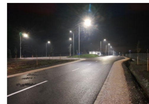
KORSZERŰ TÉRVILÁGÍTÁS A BELSŐ ÚT MENTÉN ÉS A PARKOLÓKBAN
