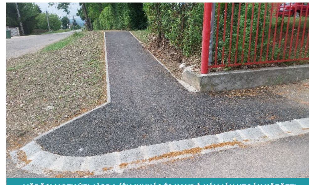
VÖRÖSMARTY ÚTI JÁRDA (ÉLMUNKÁS ÉS KANDÓ KÁLMÁN UTCÁK KÖZÖTTI SZAKASZON) FELÚJÍTÁSA
