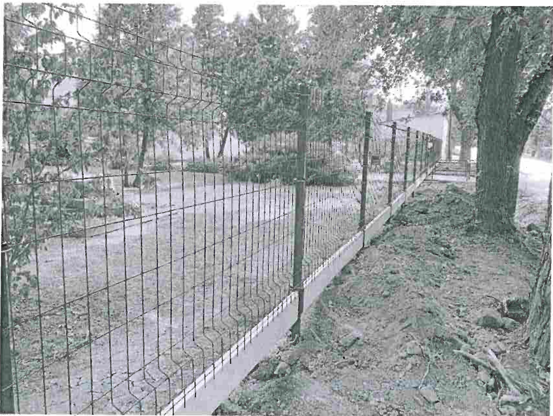
Központi Óvoda kerítés felújítás
