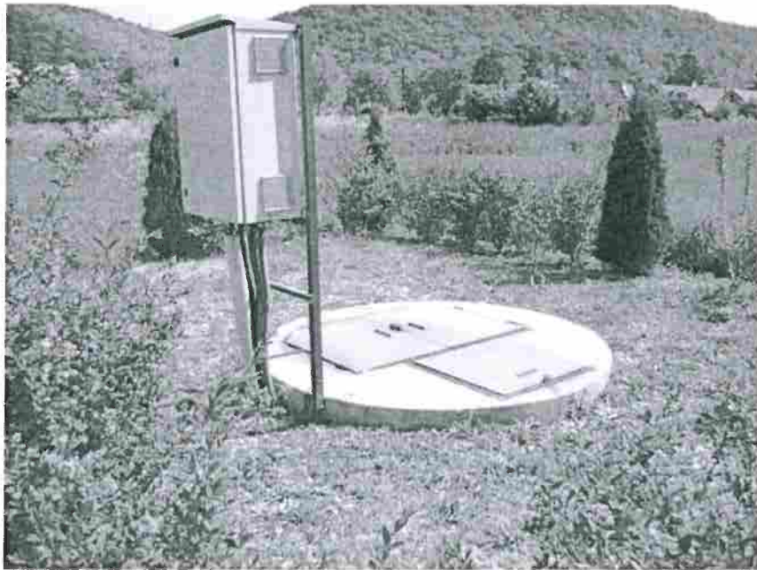
Sajószentpéter szennyvízátemelők gépészeti és villamos felújítása
