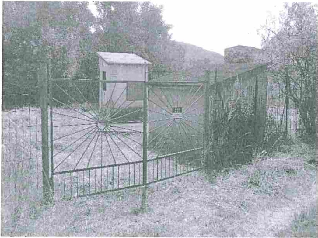
Szennyvízátemelők gépészeti és villamos felújítása
