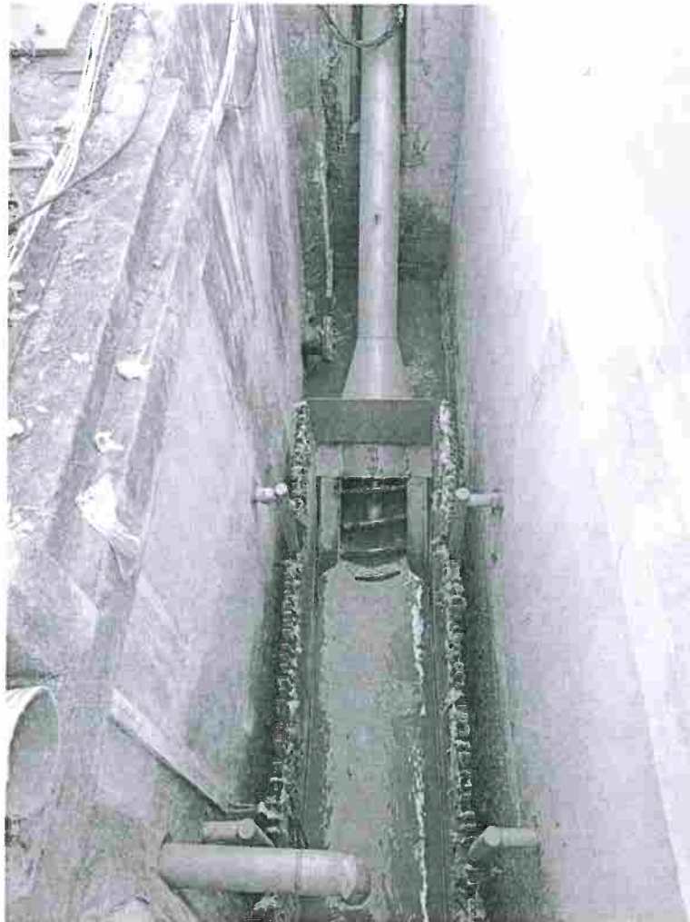
Sajószentpéter szennyvíztisztító telep - Ap 600-as gépi tisztítású finomrács
